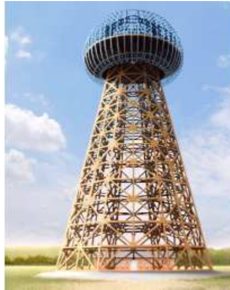
Slika 3: Rekonstrukcija stolpa v Wardencliffu, ki ga je leta 1901 začel graditi Nikola Tesla. Visok naj bi bil 50m. Terminal bi počival na leseni konstrukciji E
