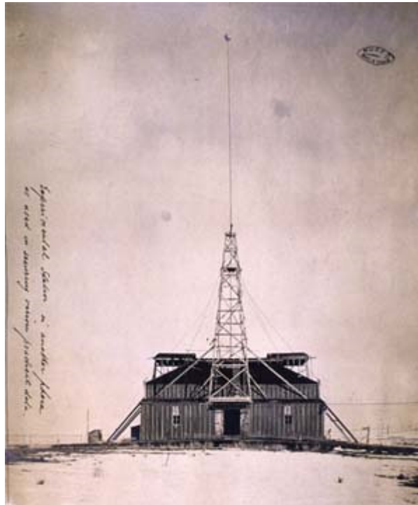
Slika 1: Prva postaja Nikole Tesla za brezžični prenos električne energije je bila visoka 16 m in je bila sposobna ustvariti strele dolge 30 m [4].
