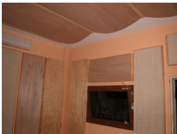
Slika 10: Policilindrični absorberji na stropu v zvočnem studiu. Na stenah so vidni tudi srednje- in visokofrekvenčni absorberji [7].
