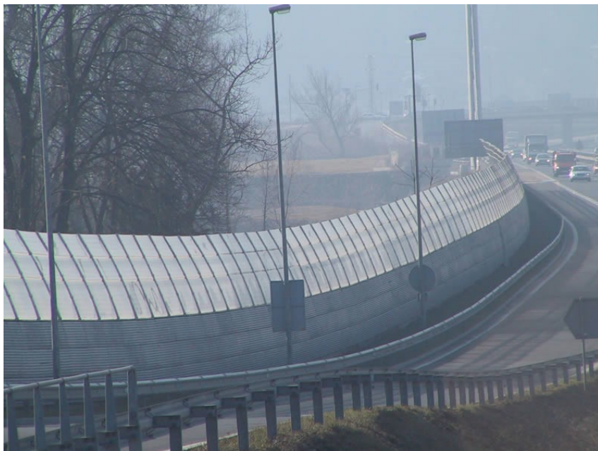
Slika 15: Nagnjena transparentna protihrupna ograja debeline 15 mm na ljubljanski obvoznici. Nagnjena protihrupna ograja je tukaj uporabljena zaradi bližine bivališč [8].
