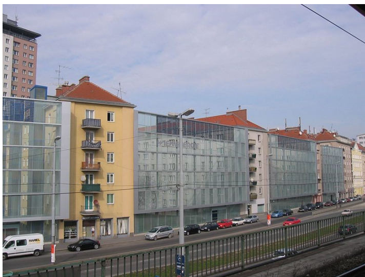
Slika 17: Protihrupni zid v stanovanjskem naselju Theodor-Körner-Hof. Zaradi močno povečanega hrupa v naselju so v sodelovanju z EU izpeljali pionirski projekt protihrupne zaščite. Na vrhu vidimo sončne celice [4].
